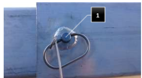
Kuva 130: Pultin asettaminen
